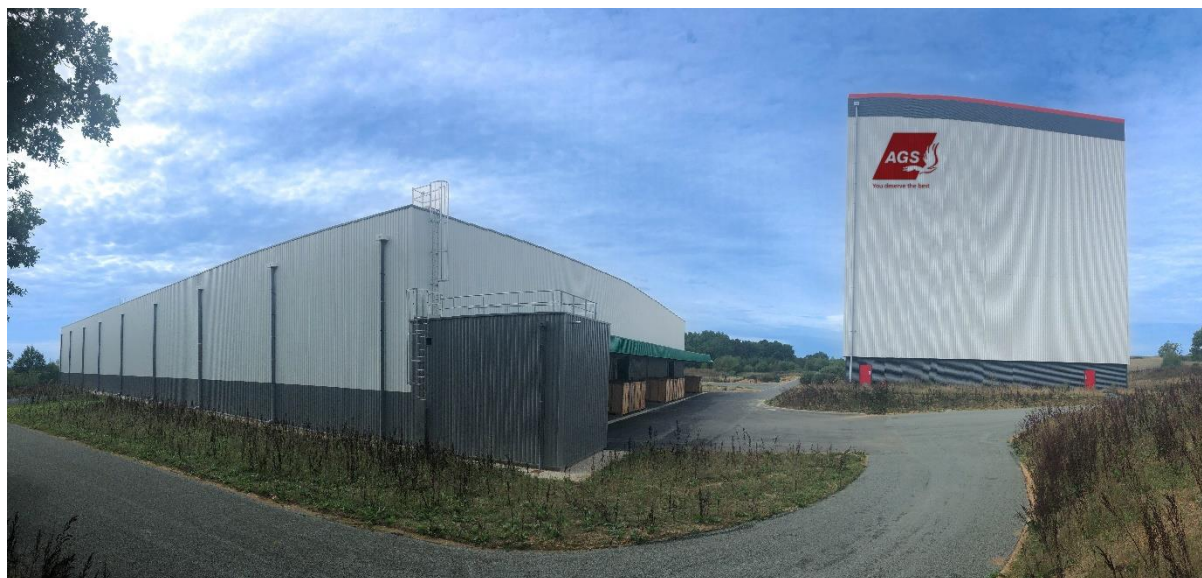
Bâtiments de Luigny 3 – garde-meubles de caisses et Luigny 2 – garde-meubles de conteneurs
